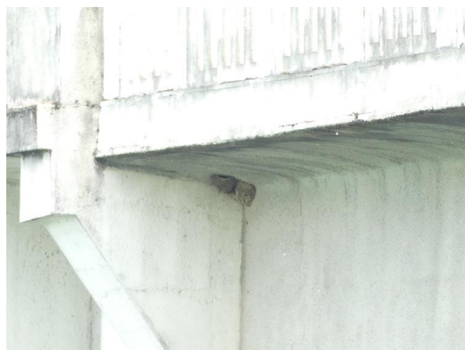
Observation de nids d'Hirondelle de fenêtre sous le pont
